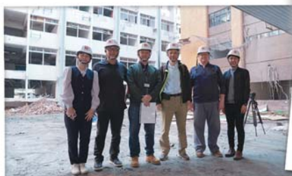
汀州華神大樓拆除主結構工程
